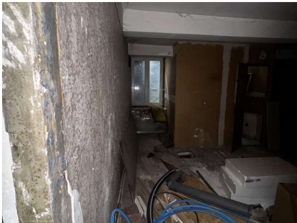
Pièce en cours de démolition, à l'étage.
