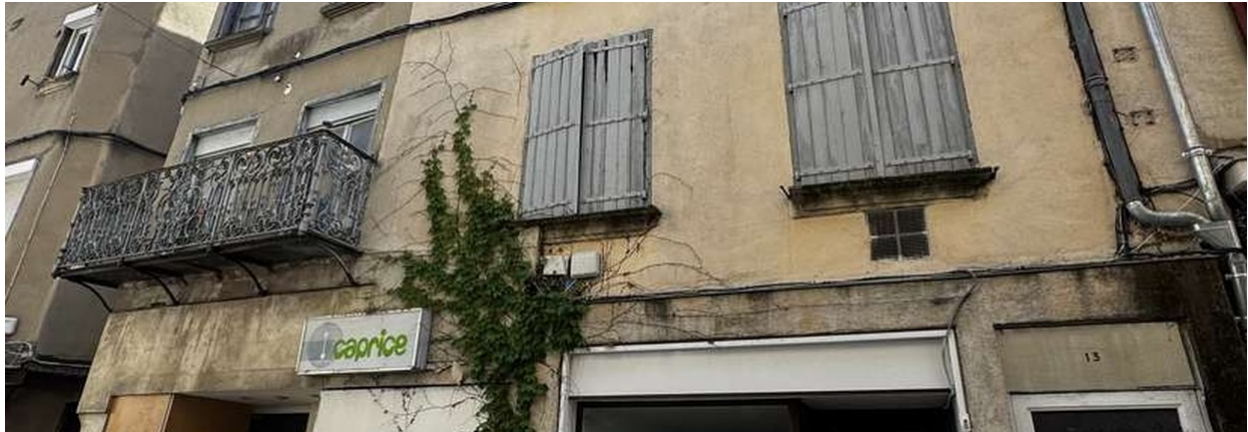
Les 11 et 13 rue Victor Hugo, façade sur rue — l'emprise du projet, à quelques mètres de l'hôtel.
